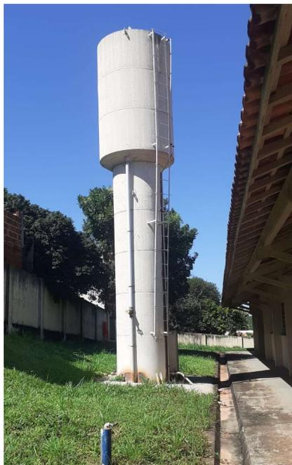
**UNIDADE 3- CRECHE MARIA PIOVESAN BIM** → 01 (uma) caixa d'água tipo torre, em anéis de concreto, CONFORME IMAGEM, com capacidade de 20.000 litros.
